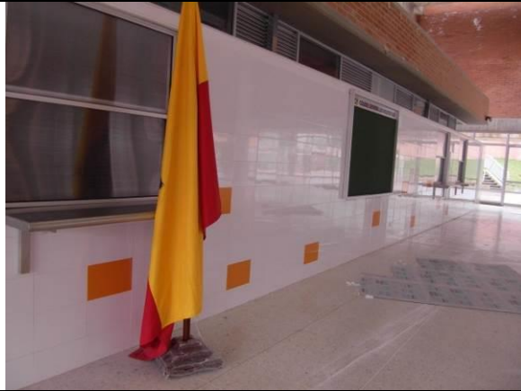
Fachada interna cocina
