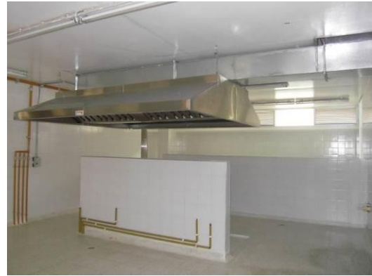
Campana extractora, cocina sin dotación.
