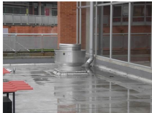
Cubierta sobre cocina.
